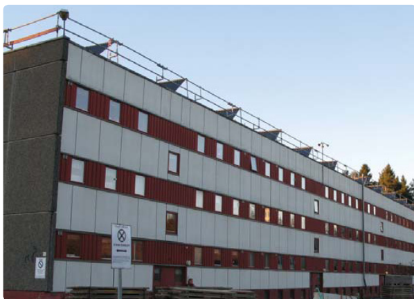
Fasade før oppgradering. Foto: SINTEF Byggforsk
